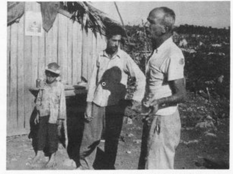
En la construcción del Centro Comunal de Guanahacabibes se emplean obreros de la región, bajo la orientación técnica del ingeniero Betancourt. Será una obra más del INRA.
